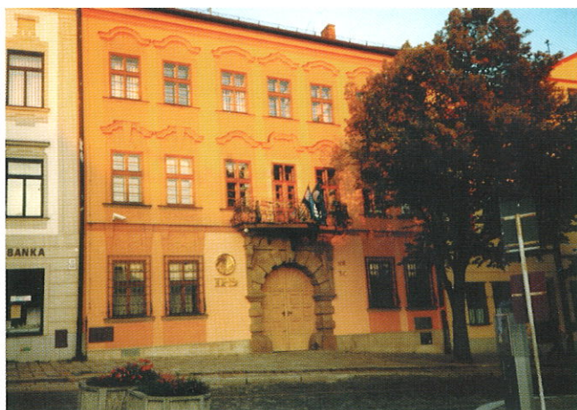
Budova staré jihlavské pošty - dnešní Investiční a poštovní banka
